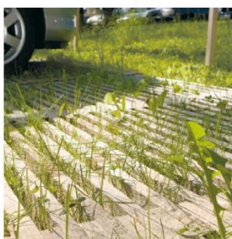
Exemples de surfaces semi-perméables pour les stationnements
