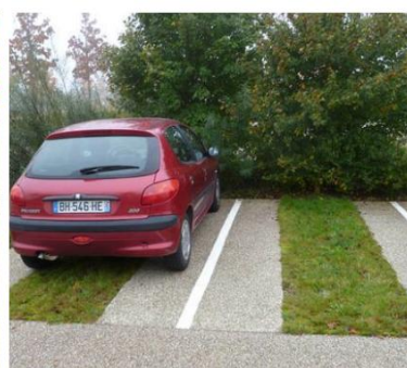
Surfaces semi-perméables stationnements
